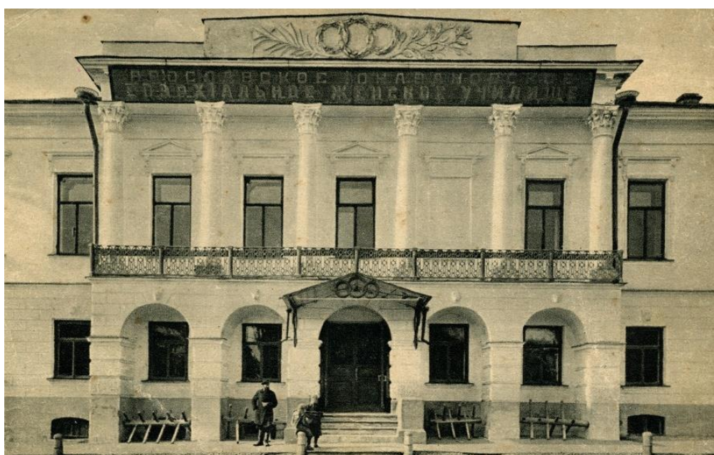
Рис. 2. Чугунная решетка и навес над входом в здание Епархиального Ионафановского женского училища
