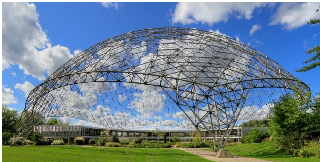
Рис. 1. Стальной двухпоясной купол
