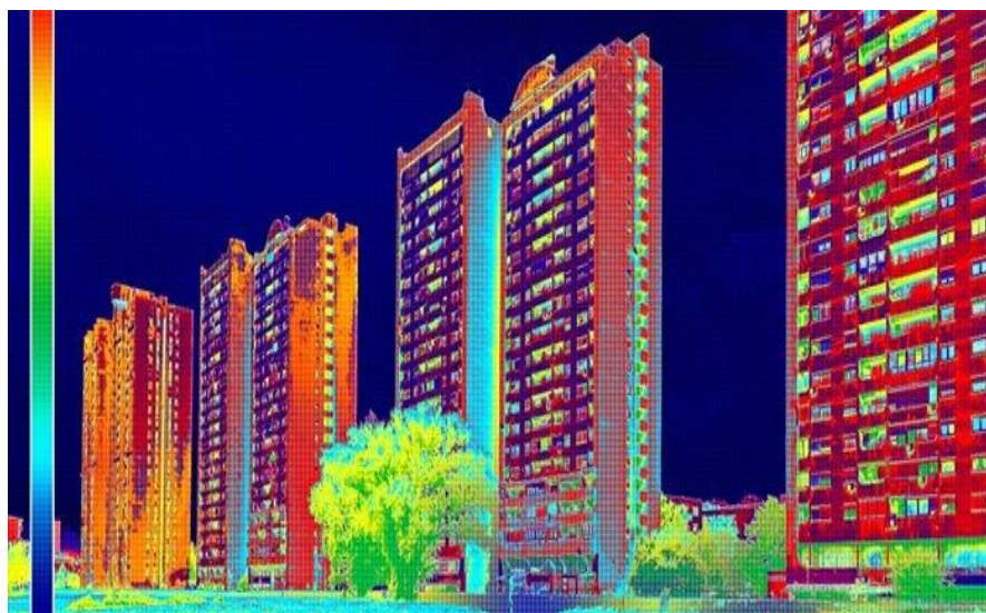
Рис. 1. Тепловизионное исследование городской застройки
