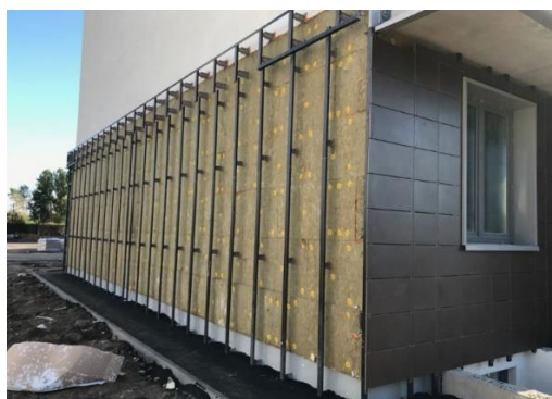
Рис. 3. Теплоизоляция и облицовка: этапы фасадных работ
