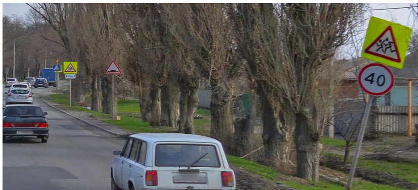
Рис. 4. Отклонение опоры дорожных знаков 1.23 «Дети» и 3.24 «Ограничение максимальной скорости»
