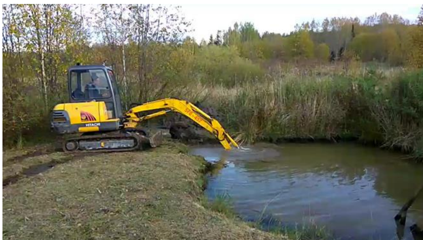
Рис. 3. Работы по формированию котлована бульдозеров
