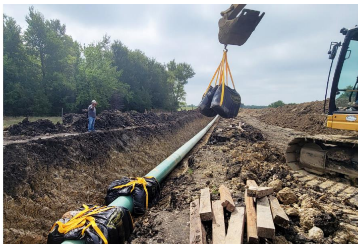
Рис. 1. Установка и монтаж геотекстильных утяжелителей
