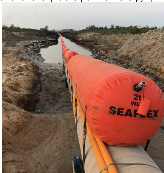
Рис. 3. Пример использования надувных модулей плавучести
