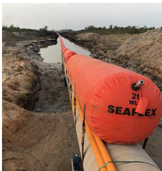
Рис. 3. Пример использования надувных модулей плавучести
