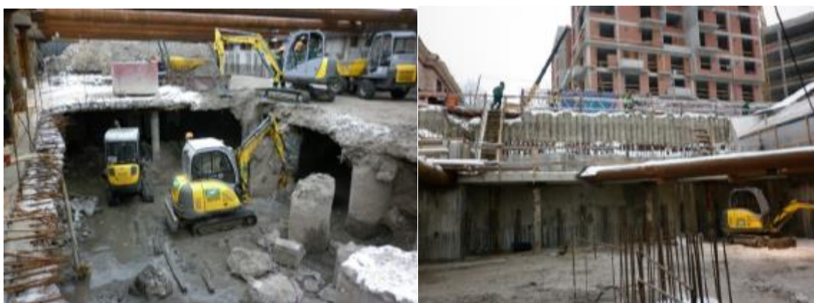
Рис. 5. Устройство подземной части здания областного Арбитражного суда г. Санкт-Петербурга
