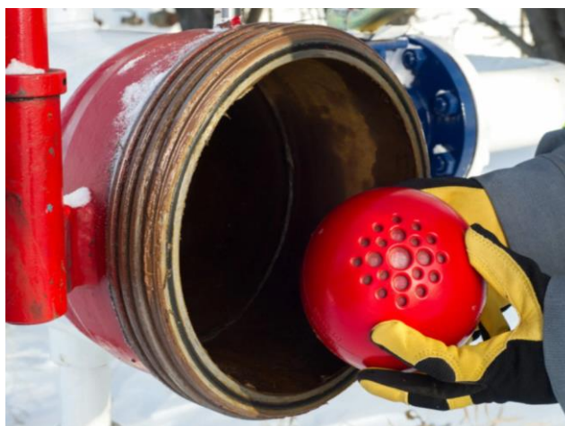
Рис. 3. Применение SmartBall для обнаружения утечки трубопроводе
