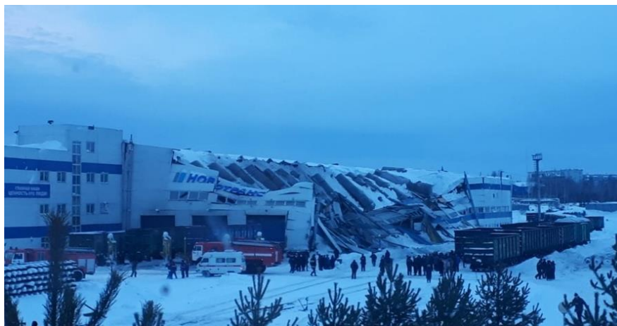
Рис. 1. Обрушение кровли вагоносборочного цеха Кузбасского вагоноремонтного предприятия «Новотранс»
