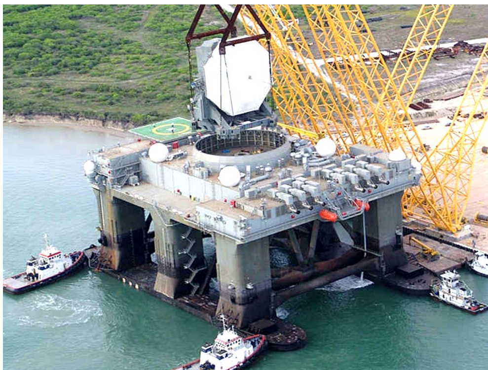
Рис. 2. Ремонт радара SBX-1.[10]
