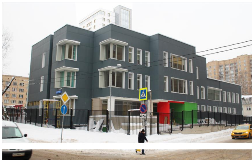
Рис. 2. Восточный фасад здания ДОО со стороны Новопресненского переулка
