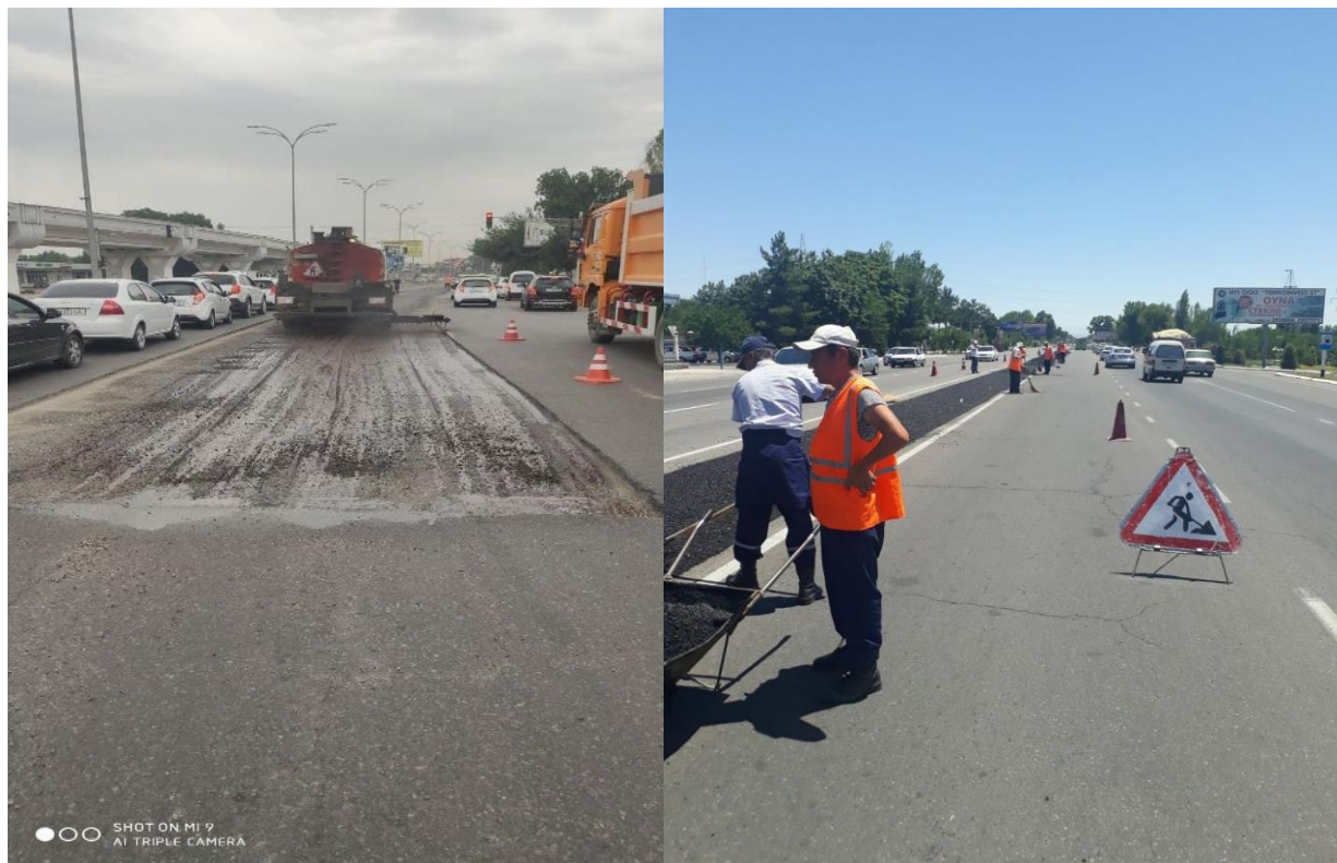
Рис. 3. Положение установленных дорожных знаков и ограждений на ремонтируемом участке дороги
