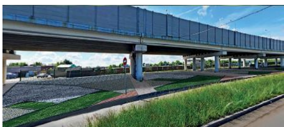
Рис. 9. Отделка участка под эстакадой с использованием различных видов покрытий (асфальт, искусственный газон, резиновое покрытие)
