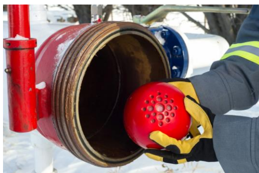
Рис. 1. Применение SmartBall для обнаружения утечки трубопроводе
