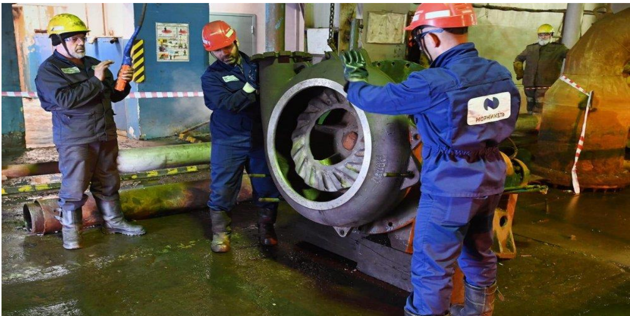
Рис. 3. Распечатанная деталь улитки на 3D-принтере
