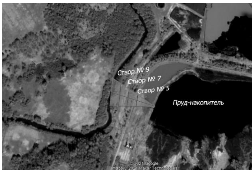
Рис. 1. Зона затопления при аварийном разрушении дамбы пруда-накопителя
