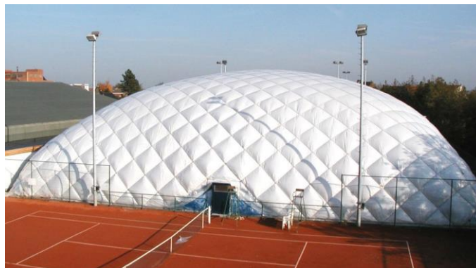
Рис. 1. Воздухопорное сооружение, усиленное канатами со средней клеткой
