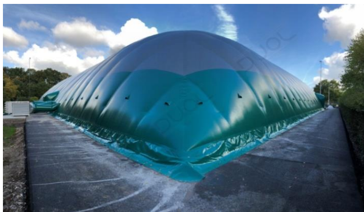
Рис. 2. Воздухопорное сооружение, усиленное стальным канатом с крупной ячейкой
