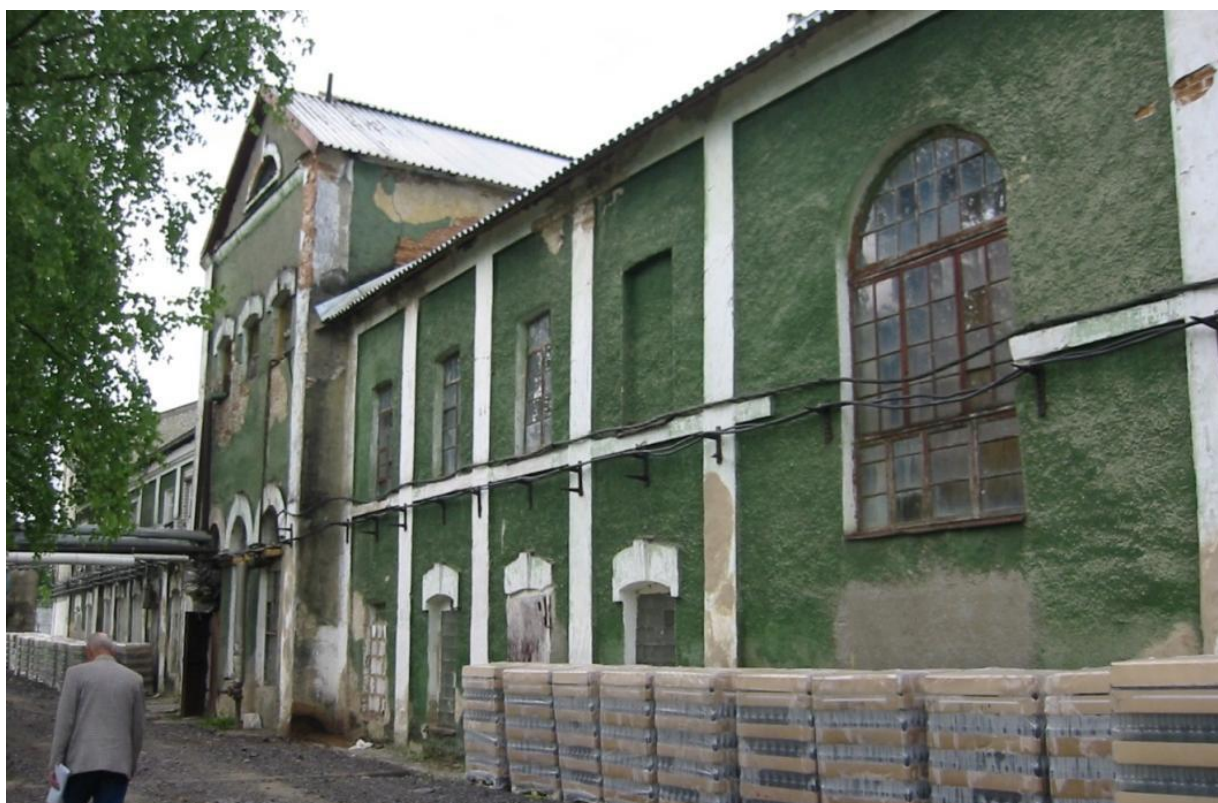
Рис. 25 Село Береговое. Здание спиртзавода, построенное Е.А. Питрой
