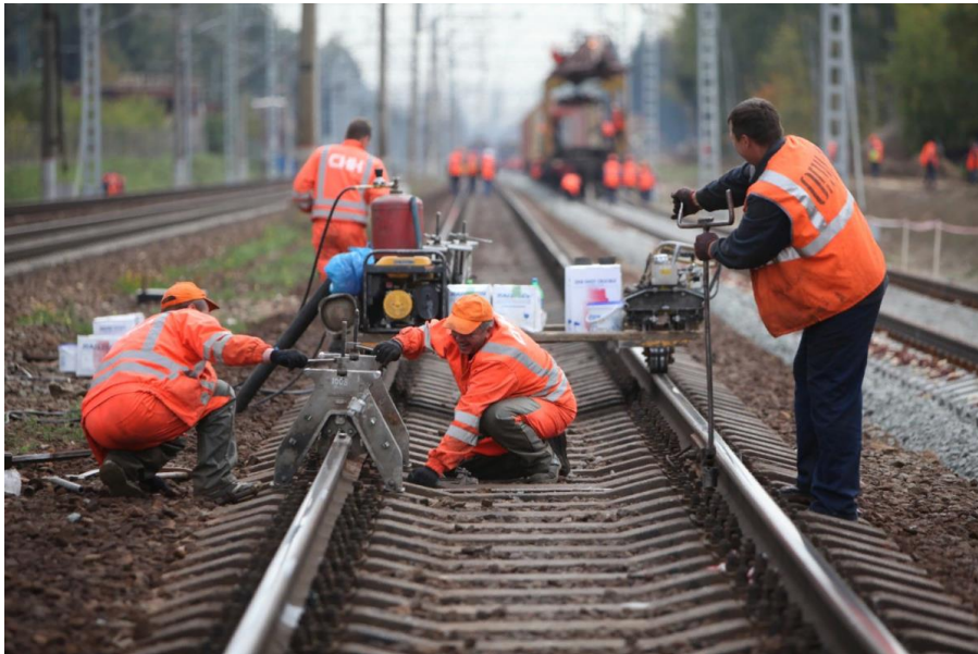
Рис. 1. Проведение ремонтных работ на перегоне железнодорожного пути
