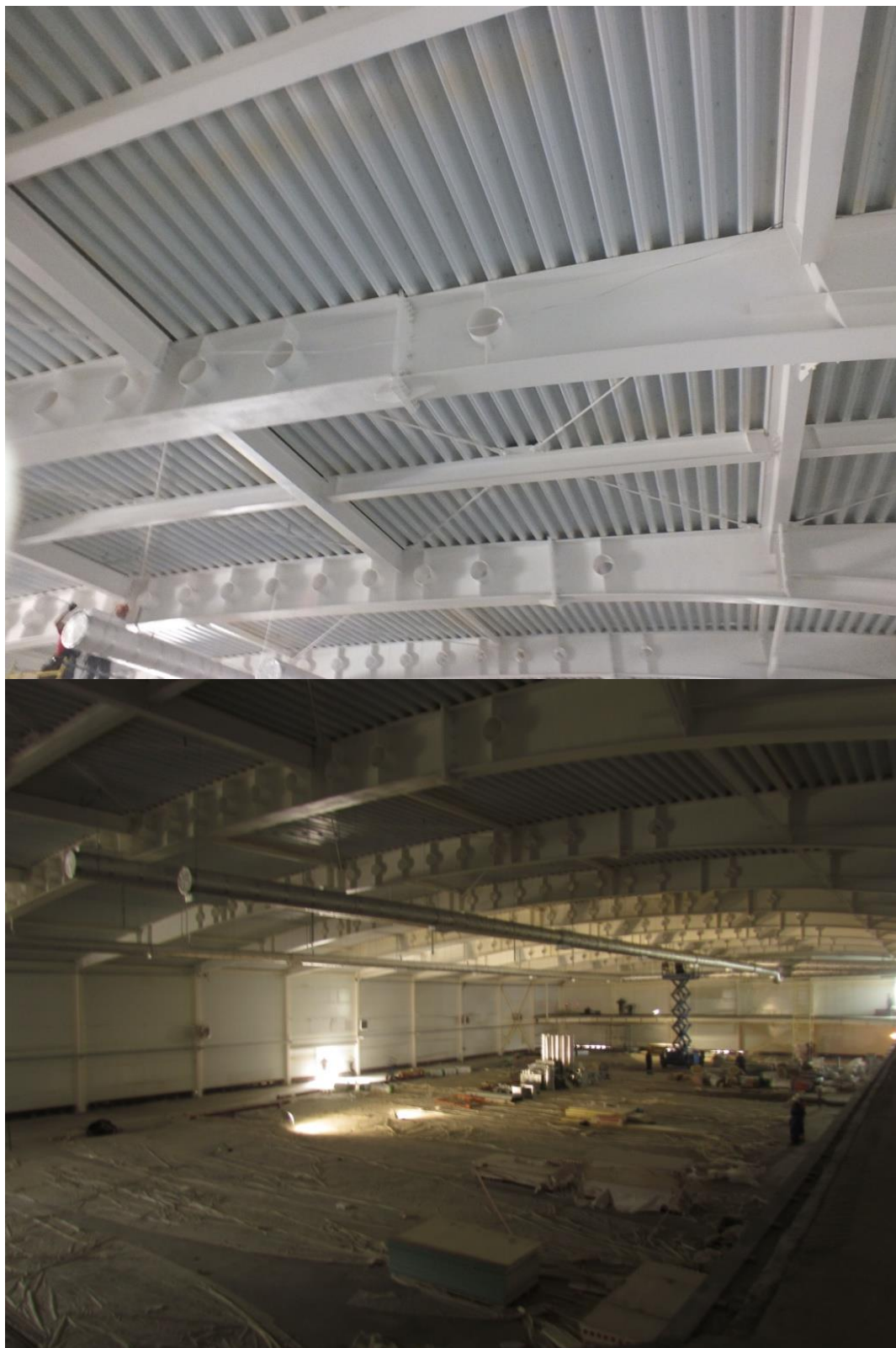
Рис. 1. Общий вид балок и связей покрытия здания, блок 1 в осях «А-К, 5-16»
