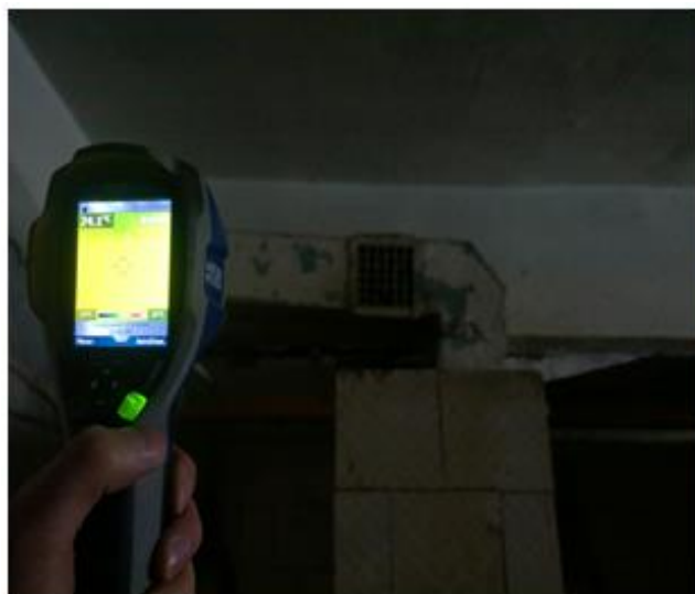
Рис. 3. Тепловизионная съемка системы вентиляции водомерного
