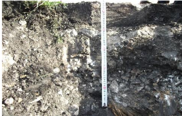
Рис. 6.1. Подстилающие слои фундамента противопожарного резервуара
