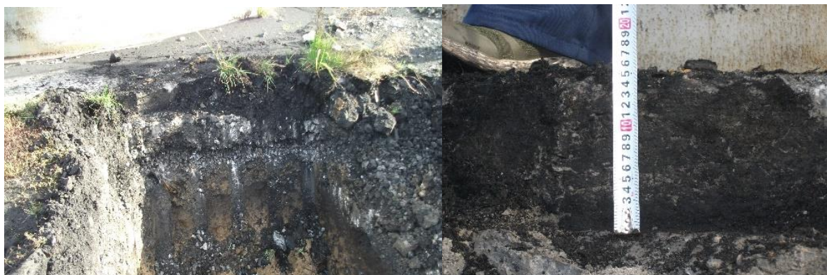
Рис. 6. Шурф фундамента противопожарного резервуара
