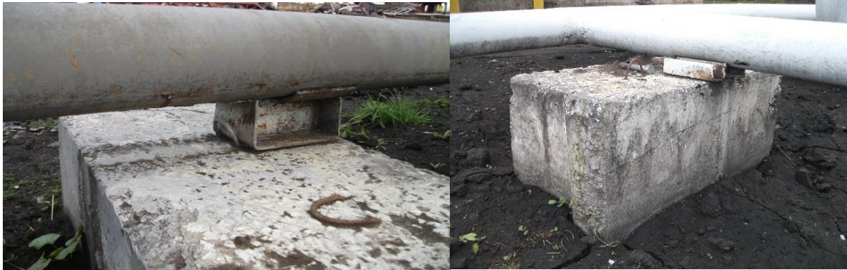
Рис. 2. Металлическая опора трубопровода и железобетонный блок под металлической опорой
