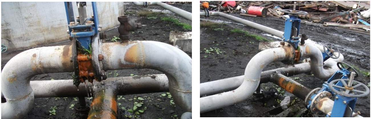
Рис. 3. Задвижка подающего трубопровода холодной воды Ø 150
