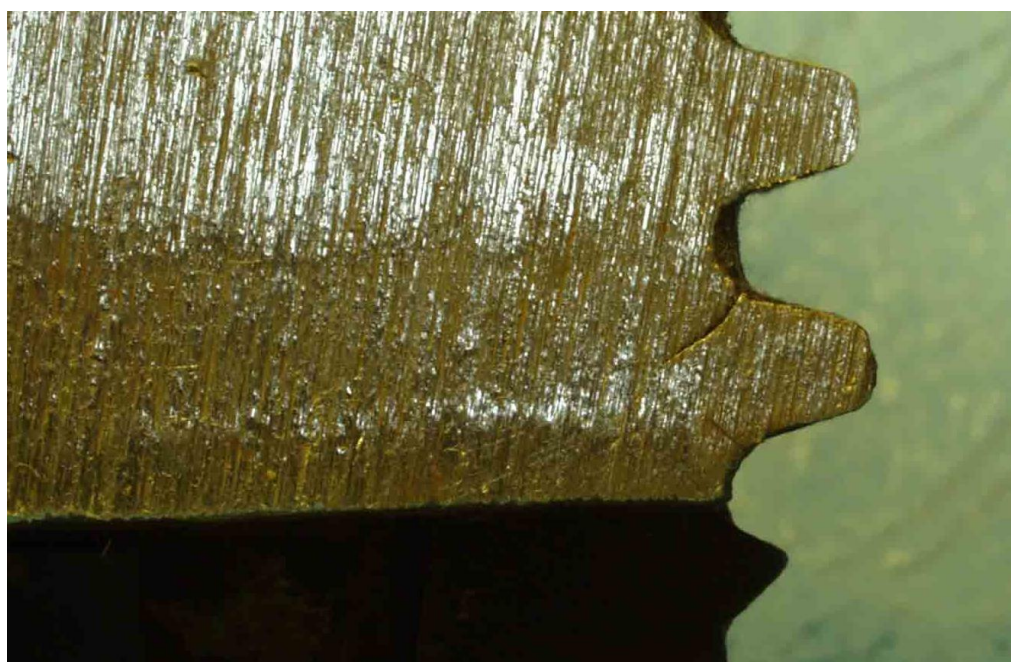
Рис. 2. Усталостная трещина в угловой впадине резьбы хвостовика двурогого крюка грузоподъемностью 40 т портального крана «Атлант», рег. № 51844-к
