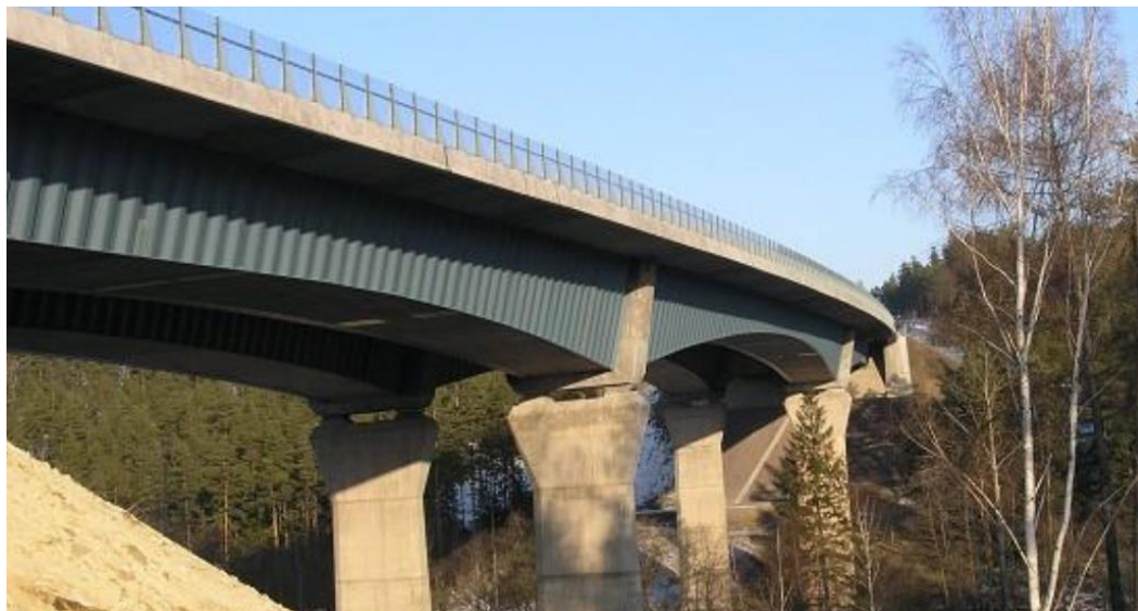
Рис. 7. Мост «Altwipfergrund bridge», Германия
