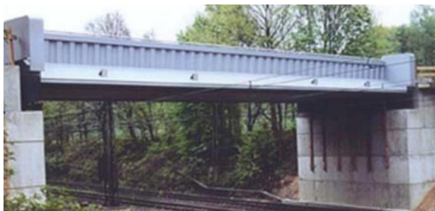
Рис. 10. Автомобильный балочный однопролётный путепровод над железнодорожными путями с гофрированными стенками с ездой понизу, Нидерланды
