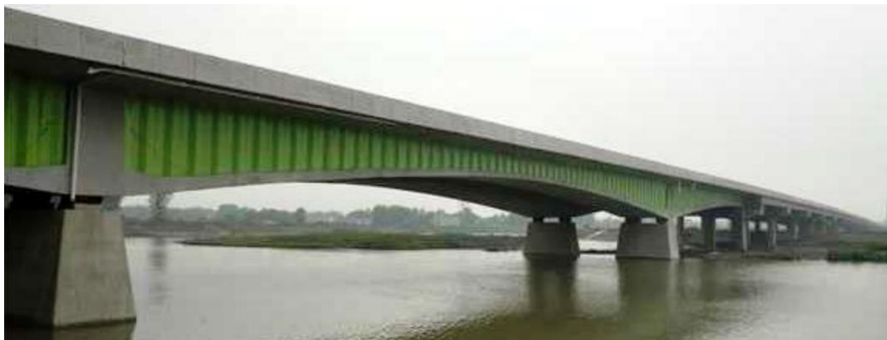
Рис. 8. Мост «Chuhe bridge», Китай
